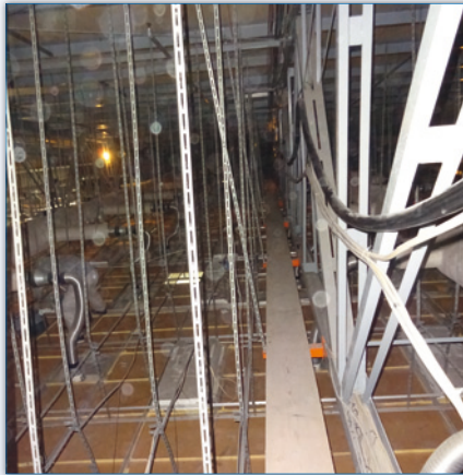
Laufwege in der Decke
