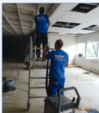
Zum Schluss Einlegen der neuen Vliese: Teamwork, Hand-in-Hand
