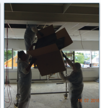
Zum Schluss Einlegen der neuen Vliese: Teamwork, Hand-in-Hand
