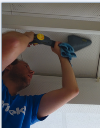
Geht nicht – gibt's nicht: Überkopfarbeit an der Decke
